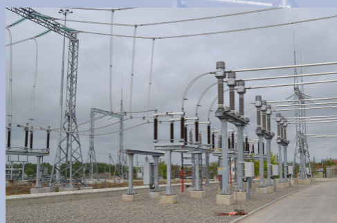
•110 kV transformatorių pastatų metalo konstrukcijos
