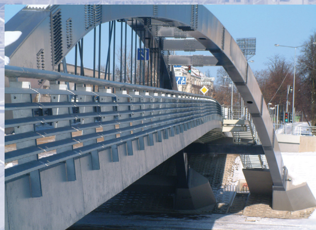
•Tiltų metalinės konstrukcijos
