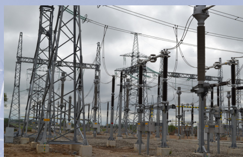
•330 kV transformatorių pastatų metalo konstrukcijos
