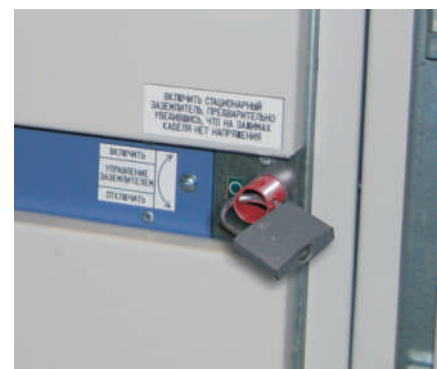
Įžemiklio valdymo mechanizmo užrakinimas
