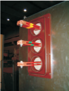
Magistralinės šynos su lietomis epoksidinėmis izoliacinėmis pertvaromis
