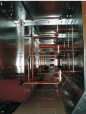
Šynos be liėtų epoksidinių izoliacinių pertvarų
