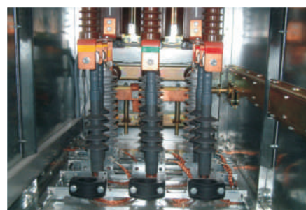
Kabelių tvirtinimas ir kabelių įžeminimo troselių prijungimas
