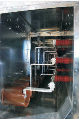
Šynos be liėtų epoksidinių izoliacinių pertvarų
