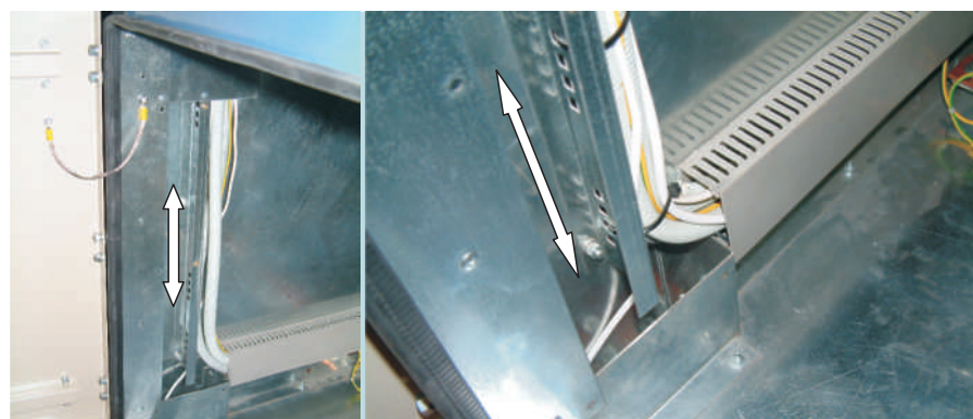
Antrinės komutacijos grandinių praklojimas į kabelių skyrių
