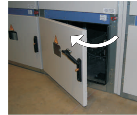
Kabelių skyriaus durelių atidarymas
