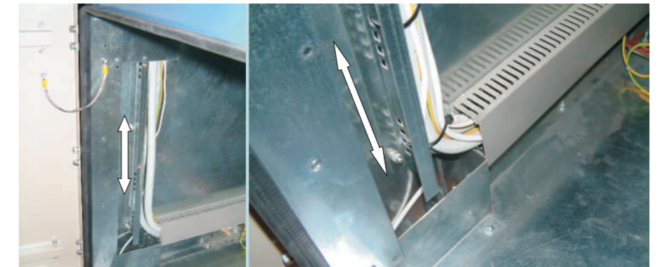
Antrinės komutacijos grandinių praklojimas į kabelių skyrių
