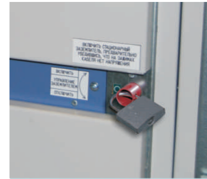
Įžemiklio valdymo mechanizmo užrakinimas
